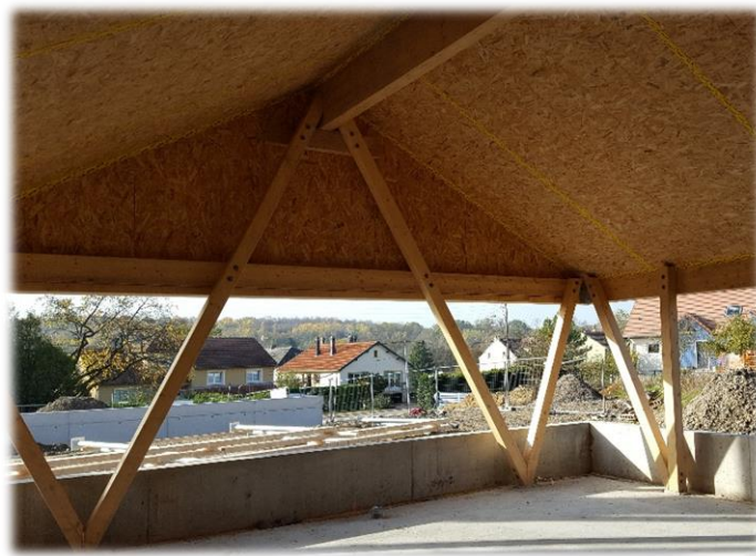
Salle de classe (vue de l'intérieur)
