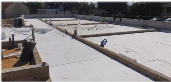
Le réseau d'évacuation des eaux du bassin de rétention a été créé fin août rue de Lilette. La mise en place de l'**isolation sous-dallage** a été finalisée et la dalle béton sera coulée la semaine du 14 au 18 septembre. L'entreprise en charge de la charpente et de l'ossature bois interviendra à compter du 21 septembre.
