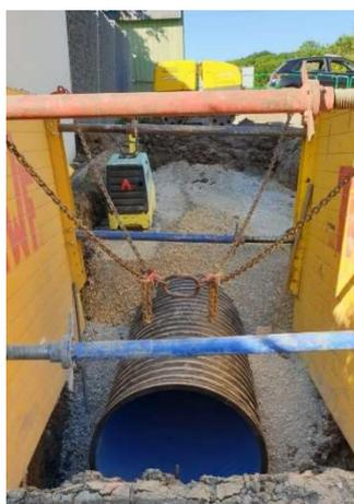
Tuyau de 1000 mm canalisant les eaux pluviales en direction de l'Anzeling
